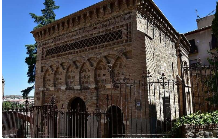
Bâbü Merdüm Camii / Tuleytula (Cristo de la Luz Camii)
